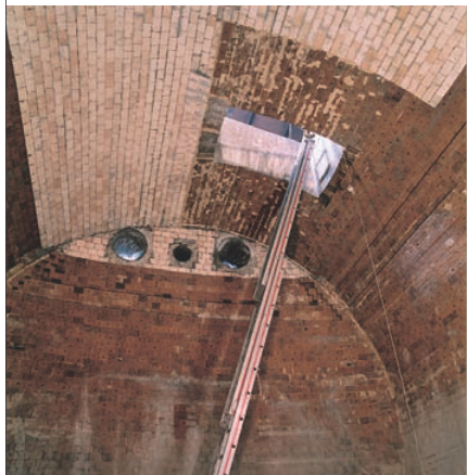
Gewölbe mit Eingussöffnung
