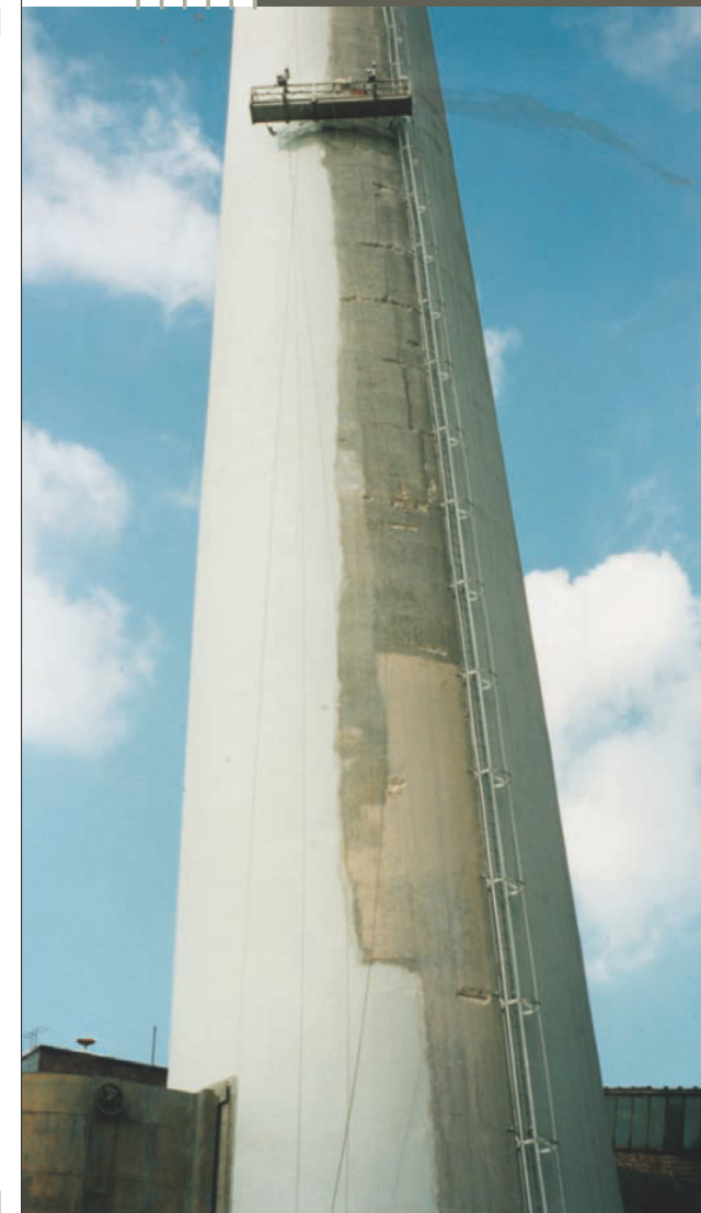
Betoninstandsetzung an einem Stahlbetonschornstein in 100 m Höhe
