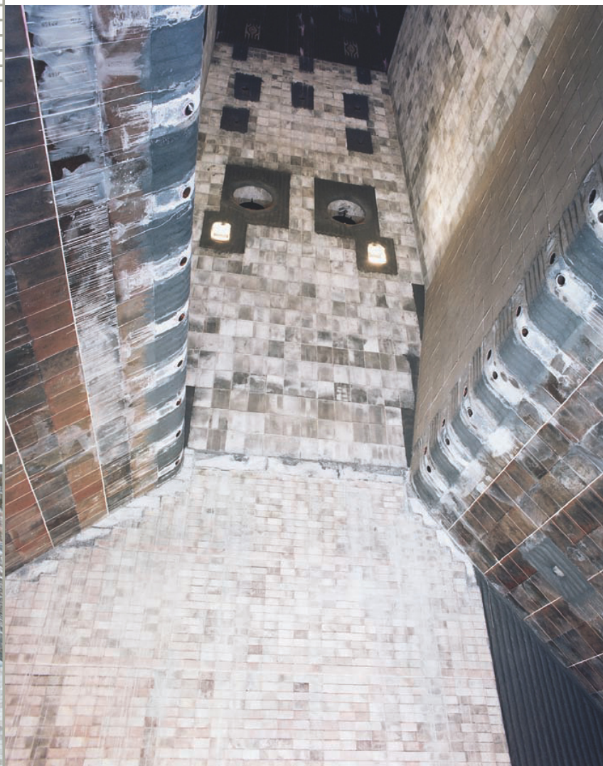
Zünd- und Stützbrenner in der Seitenwand
