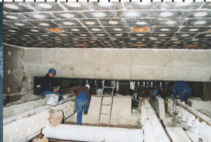
FF-Ausmauerung eines Stoßofens
