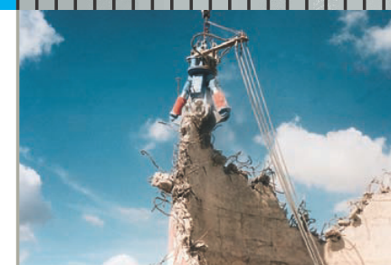
Schornsteinabbruch mit handgeführten hydraulischen Abbruchwerkzeugen
