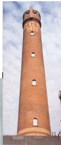
Rekonstruktion eines Schrottturmes
