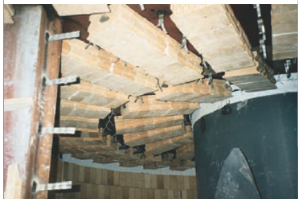
Decke eines Zyklons in einem Zementwerk
