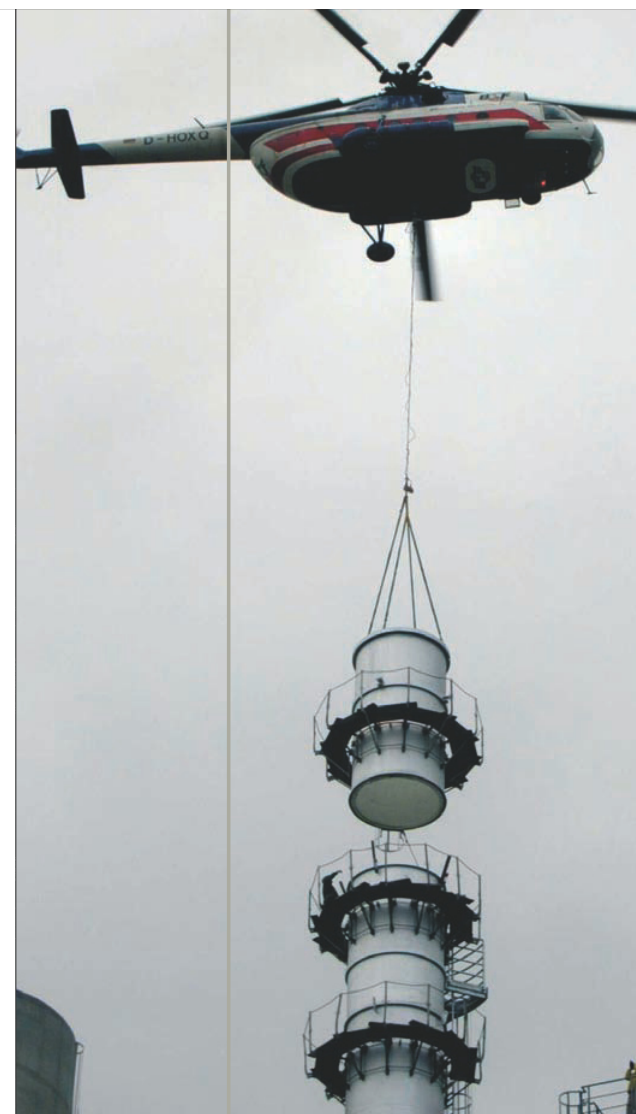
Hubschraubermontage
